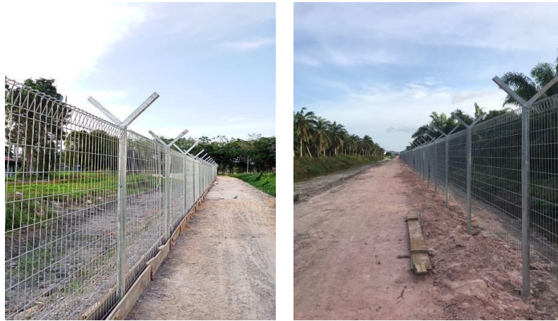
Gambar 2.1.3 : Kerja-kerja Membina Pagar Fasa 2 yang sedang dijalankan
