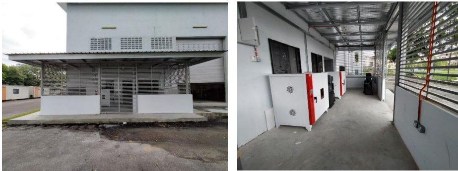
Gambar 3.6.1 Kerja pengubahsuaian yang dilakukan di Blok G8
